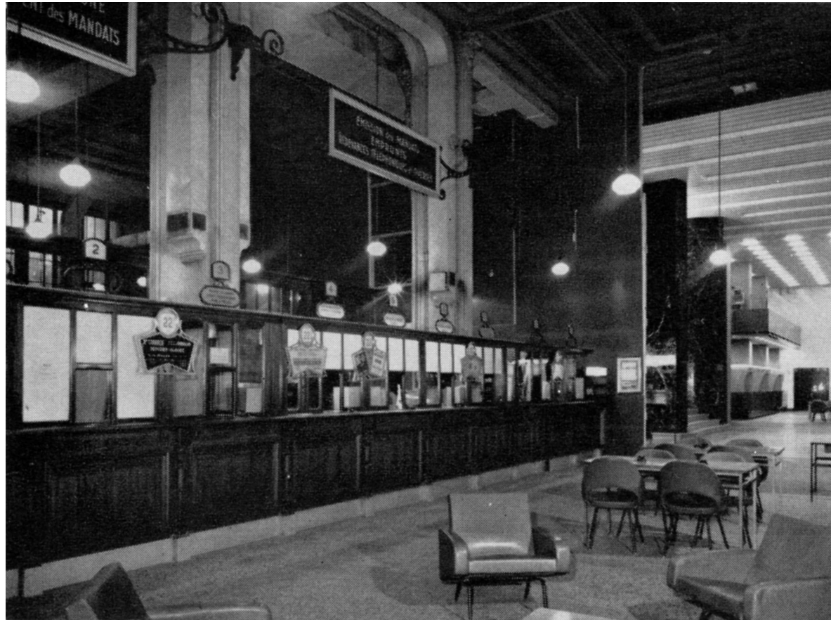
Salle des guichets en travaux, en décembre 1964 (Musée de la Poste)
