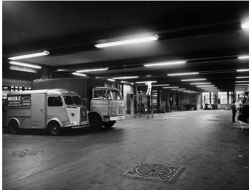
Entresollement du rez-de-chaussée, vue du chantier , novembre 1964 (Archives la Poste).
