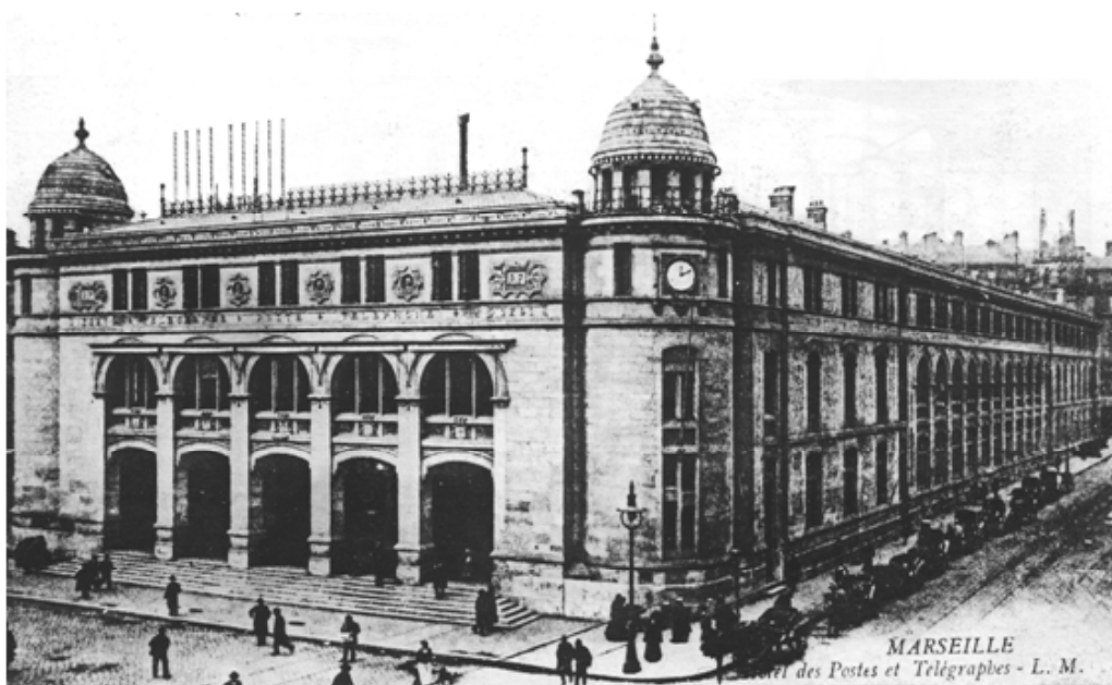
Hôtel des postes de Marseille, 1889
