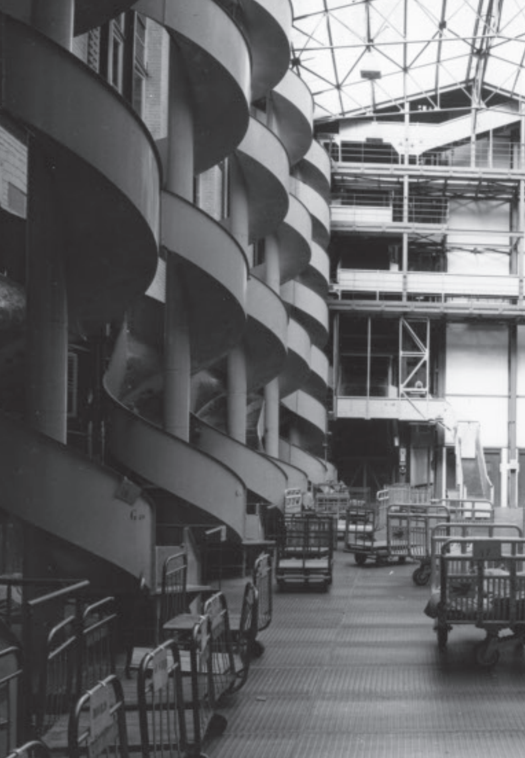
Cour du transbordement après sa transformation
